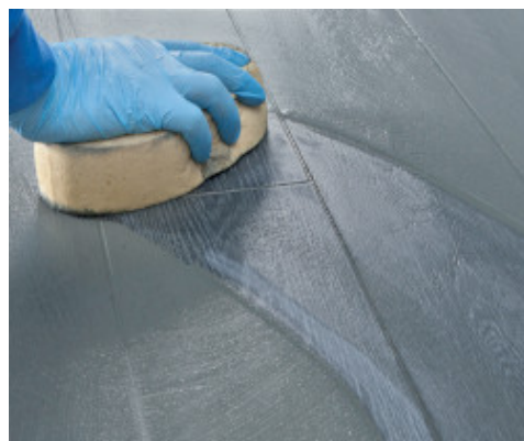
Limpieza y acabado de juntas con esponja de celulosa dura
