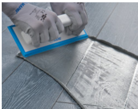
Aplicación de Ultracolor Plus con llana de goma sobre pavimentos de gres porcelánico efecto madera
