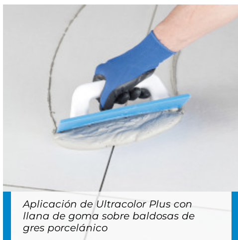
Aplicación de Ultracolor Plus con llana de goma sobre pavimentos de gres porcelánico efecto madera
