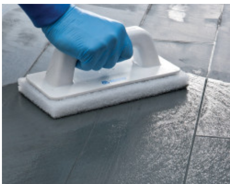
Limpieza de juntas con estropajo ScotchBrite® (cuando el producto está parcialmente endurecido)
